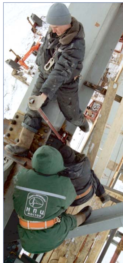
Рис. 2. Монтажные работы по сборке металлических мостовых конструкций на строительной площадке
