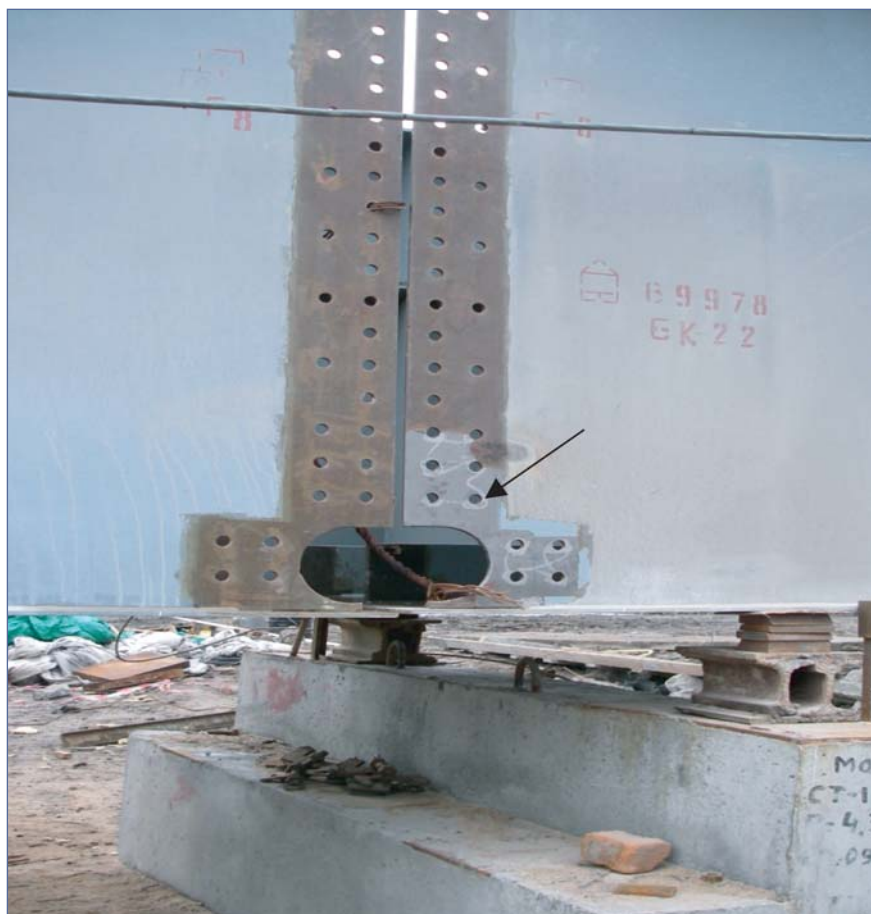
Рис. 3. Применение съемного покрытия «Контакт» для защиты монтажных поверхностей на период транспортировки и хранения пролетных строений до их монтажа. Стрелкой показано качество монтажной поверхности, очищенной абразивным методом на заводе-изготовителе после удаления покрытия «Контакт»
